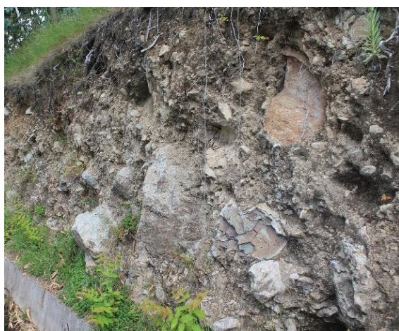
Fig. 21 Depósito coluvial asociado a la remoción en masa del Cerro Mayo de 1960.
