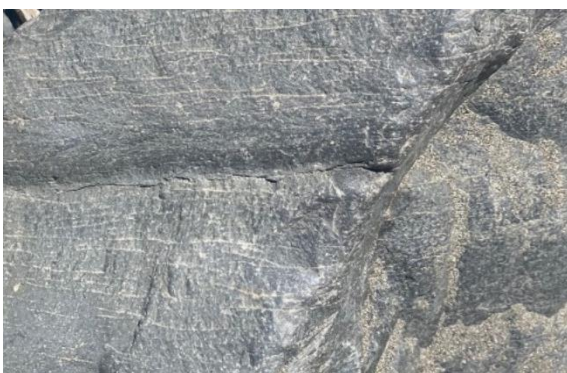
Fig. 105 Estrías perpendiculares a las caras de las columnas.
